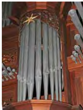
Die Pfeifen müssen zur Säuberung ausgebaut werden.
